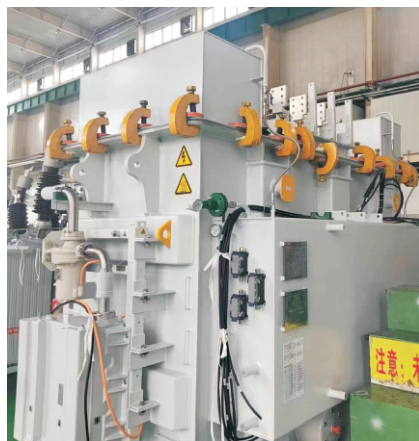
1+2相开关安装于线圈三角区
